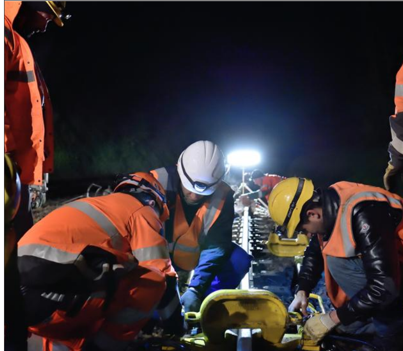
■ Changement d'un morceau de rail. Actuellement et pour tout l'été, c'est la portion Montbrison-Thiers qui est fermée par crainte de dilatation sur des rails aux attaches fragiles. Photo Frédéric CHAMBERT
